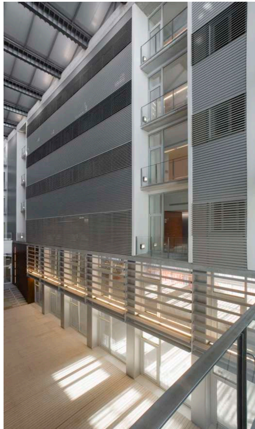
EDIFICIO SICIOSANITARIO BORBO
