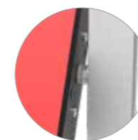
Lamas orientables: Sin clip de seguridad en eje de giro lado sin regle acc.
